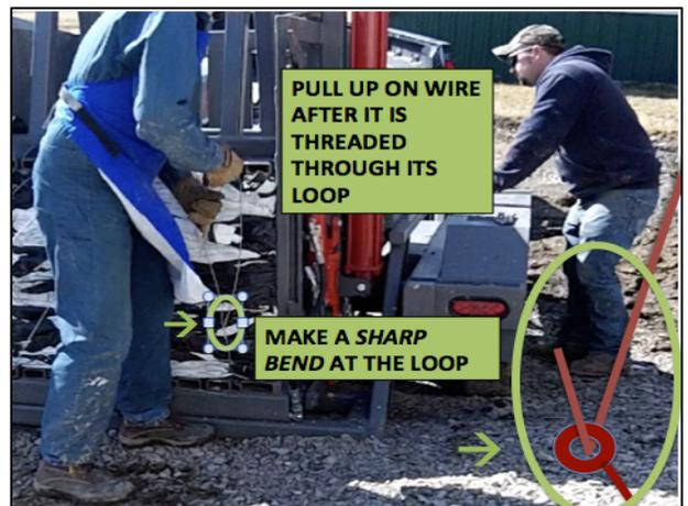
FIGURA 39E. EL ALAMBRE NO DEBE ESTAR EXCEPCIONALMENTE APRETADO, PERO ES NECESARIO TIRAR DE ÉL PARA ELIMINAR EL EXCEDENTE. DOBLE BIEN LOS ALAMBRES EN EL BUCLE.
