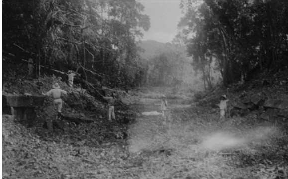
Figure 3.1. Desmonte or the clearing of great mounds of their cover of natural vegetation. Archivo Técnico del Instituto Nacional de Antropología e Historia (INAH), Dirección de Monumentos, Ignacio Marquina, “Informe de los trabajos de conservación de la Pirámide del Tajín, en Papantla, Ver.” Mexico, D.F., a 22 de junio de 1934.
