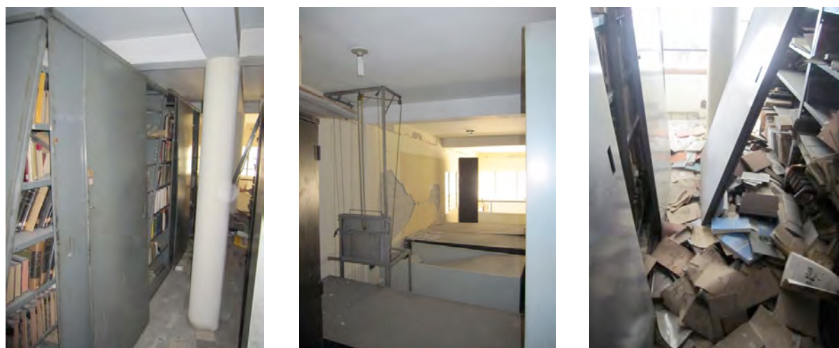
Ci-dessus : clichés de la Bibliothèque de Saint-Louis de Gonzague. Le bâtiment est peu endommagé. Un travail de tri et de protection des collections est néanmoins à entreprendre.
